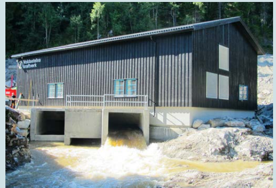
Voldsetelva kraftverk har produsert strøm siden august 2013.
