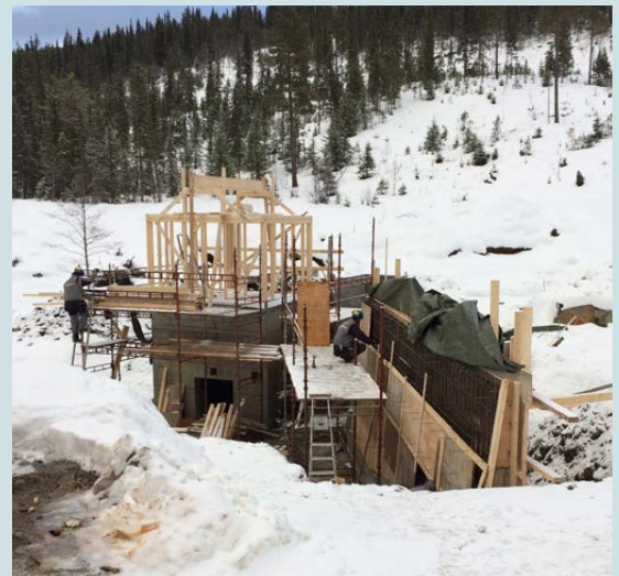
Byggingen av Kulu kraftverk har hatt fin fremdrift i vinter.
